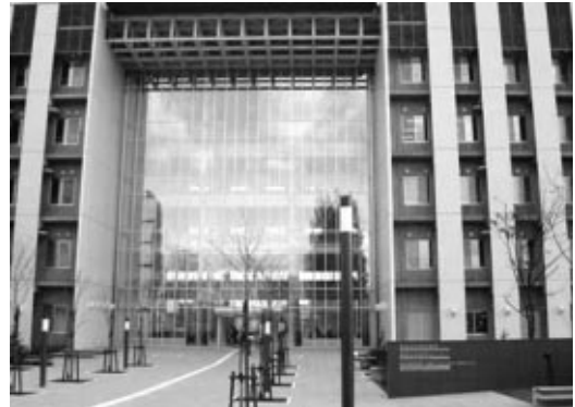
図2 酸化チタンコーティングガラス 北海道大学創成科学研究棟の西面のガラスは酸化チタンコーティングされている。可視光・赤外線カットにも効果がある
